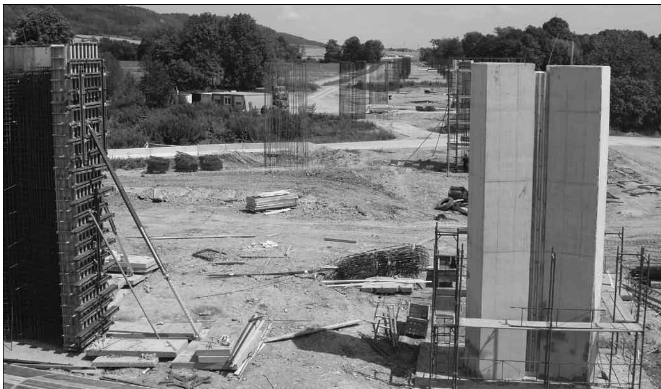
Budování dálniční estakády mezi Odrami a Vražným v r. 2007 (Foto archiv Správy CHKO Poodří).
