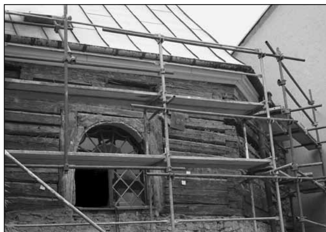
Okno s půlkruhovým záklenkem v roubené konstrukci – srovnání současného stavu a odhalené konstrukce v průběhu rekonstrukce (Foto Adam Hubáček, Radim Kravčenko).
