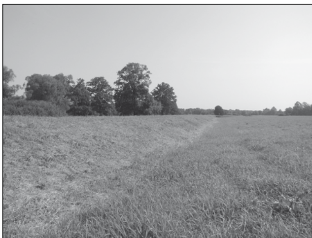
Dnes již odstraněná hráz u Bílovky v r. 2002 (Foto archiv Správa CHKO Poodří).
