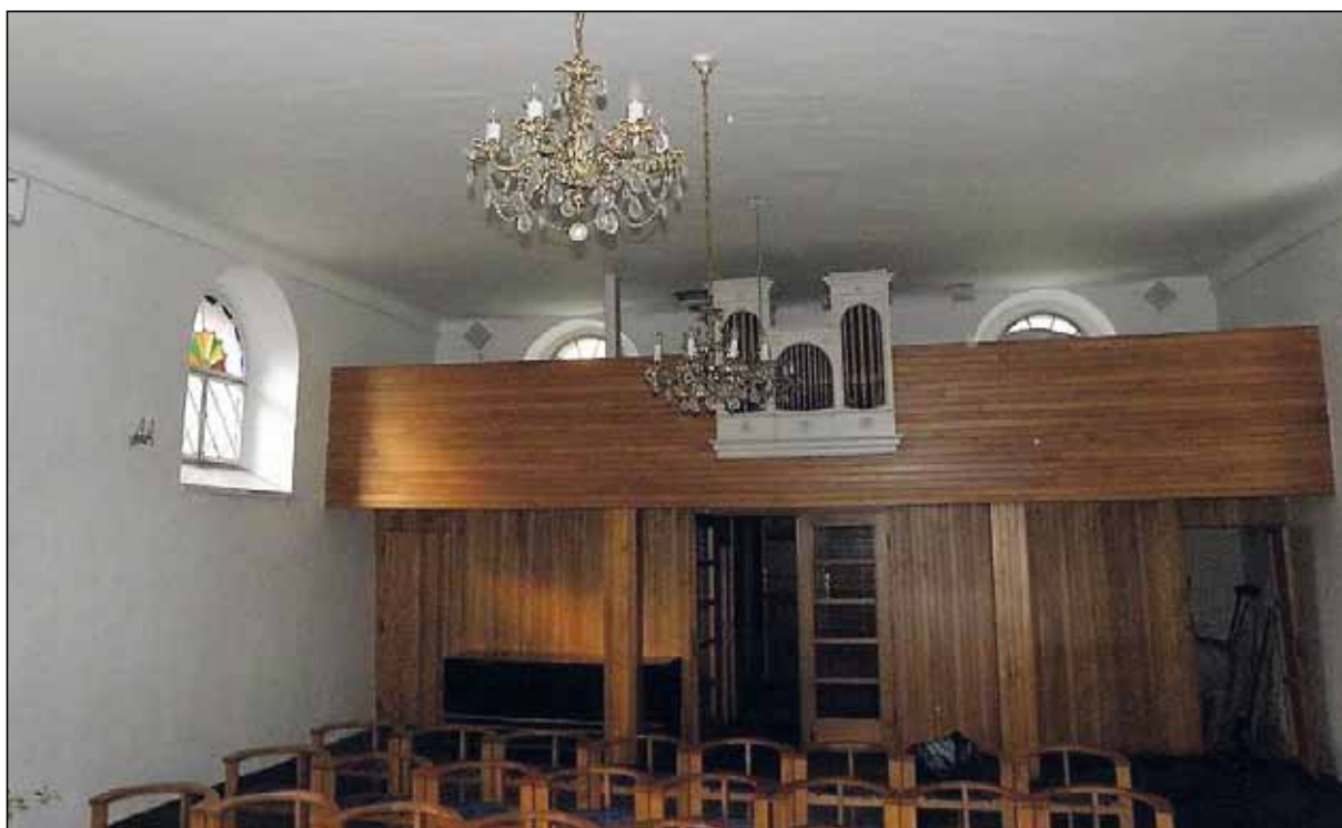
Podoba interiéru s omítnutým rákosovým stropem před rekonstrukcí z let 2015–2016.
