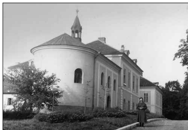
Fotografie ze strany zámecké kaple po opravě zámeckých fasád, 70. léta 20. století (Foto Muzeum Novojičínska).
