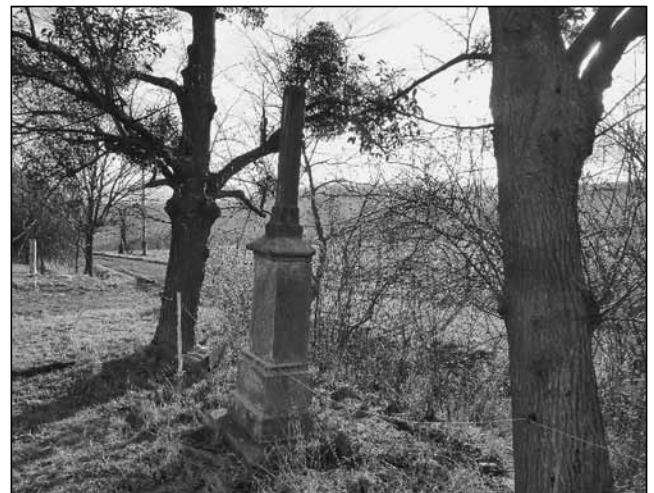
Stav kříže před opravou (Foto zapůjčil Josef Pavlíček).
